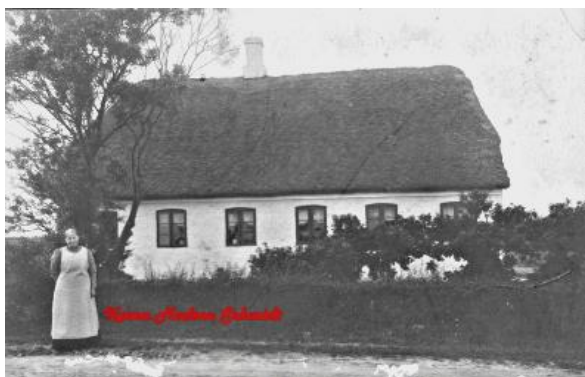
Hessellundvej 2. Kirsten og Peter Larsens første hjem fotograferet fra syd. Der har oprindeligt været lidt stald i den vestre ende. Smedjen har ligget som et selvstændigt hus. Foto ca. 1938
